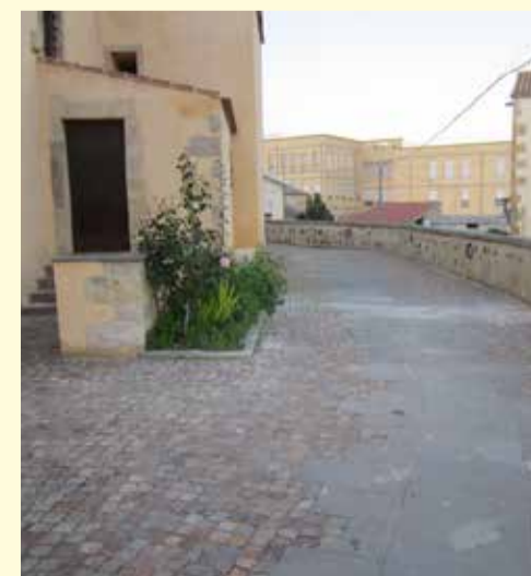
Completamento lavori retro chiesa parrocchiale
