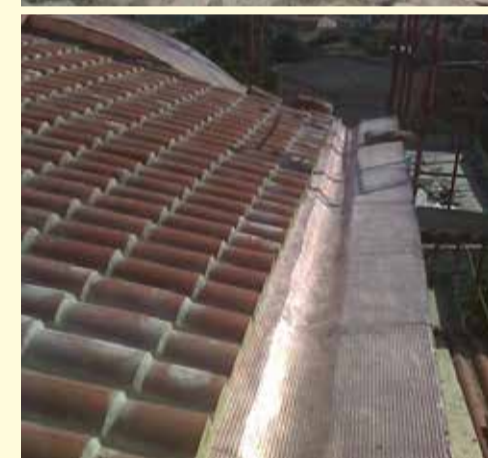
Tetto e volta della sagrestia, prima e dopo l'intervento
