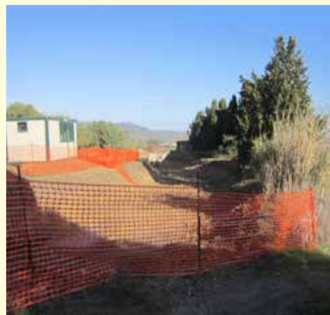
Lavori al canale di guardia per la protezione dell'abitato
